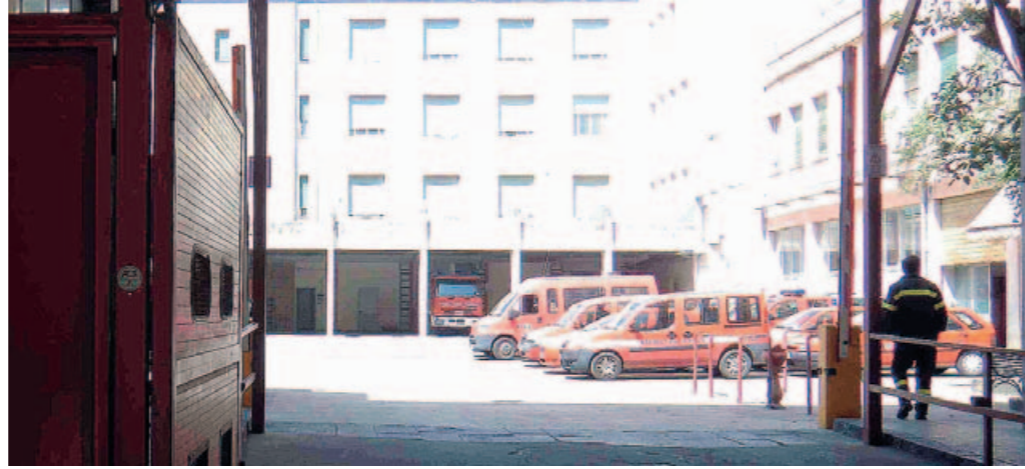
L'ingresso del Comando provinciale dei Vigili del fuoco
